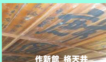
作新館 格天井
